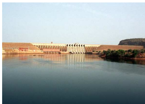
Figure 14 : le barrage de Manantali
